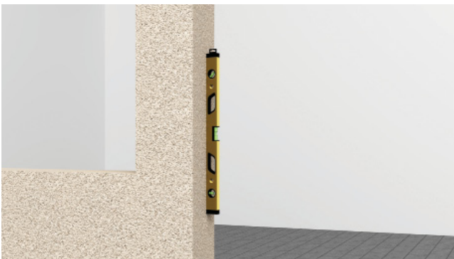
2 Contrôler les niveaux des 2 piliers; Check the straightness of the pillars;
